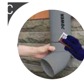
C Haluskan ujung pipa dengan amplas
