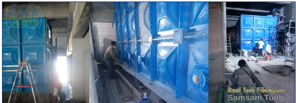
Gambar suasana pemasangan Roof Tank di Proyek
